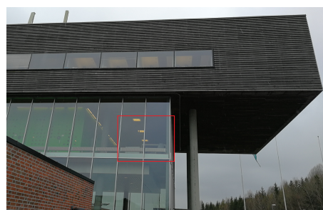
Figur 5.5: Lokasjon ovenfor hovedinngang
