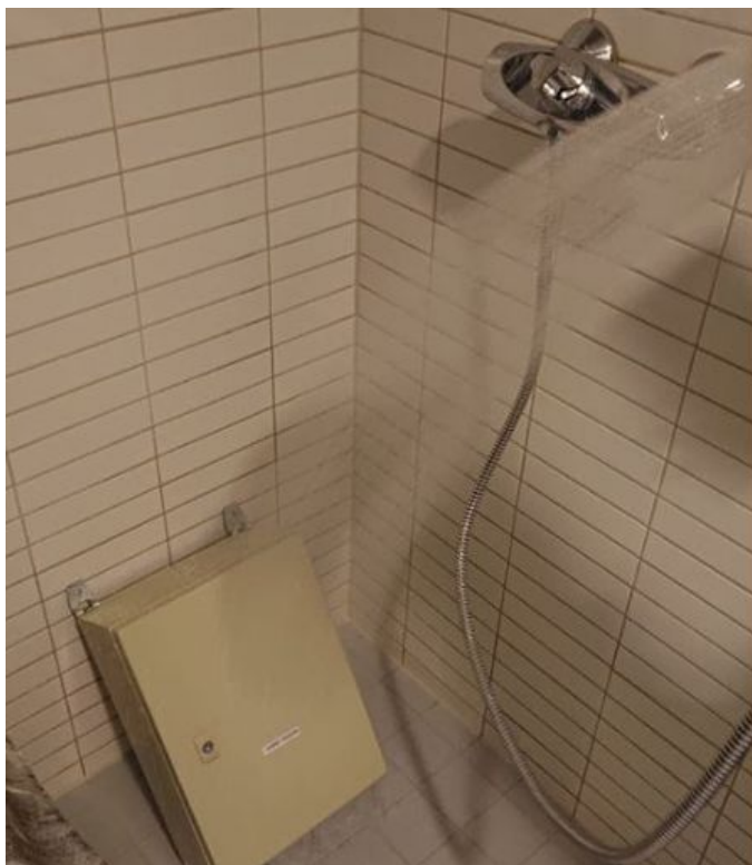
Figur 7.1. Regntest på monteringsboksen.
