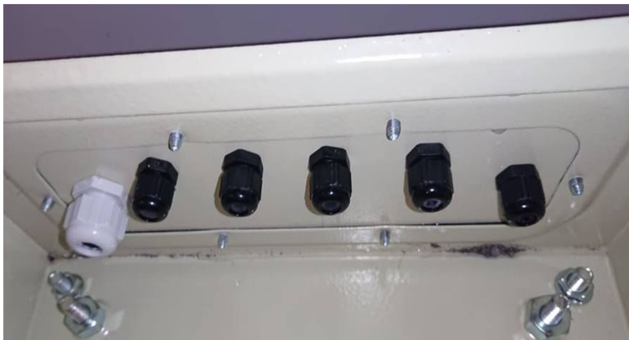
Figur 6.2. Kabelgjennomgang.
