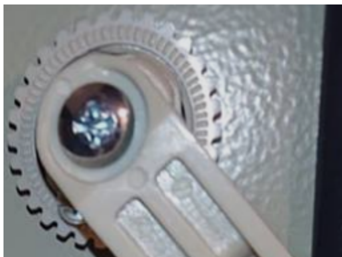
Figur 7.2. Lekkasje på innsiden av låsen.
