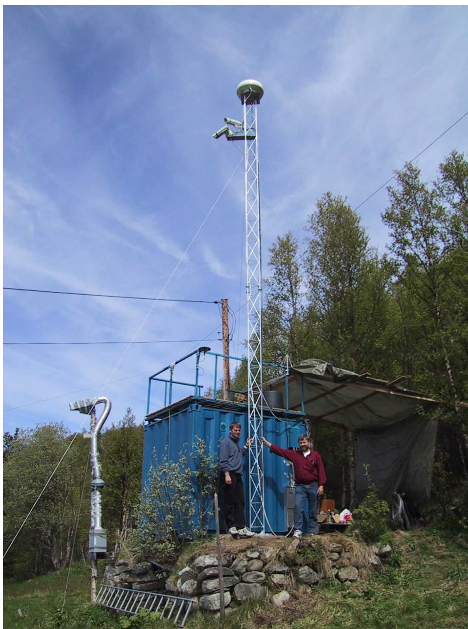
Figur 1.1: Bildet viser den nåværende automatiske målestasjonen (AMS) i Hessdalen som er tilkoblet strømmettet. 2
